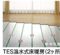
TES温水式床暖房(2ヶ所)
