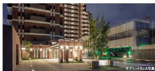
サブエントランス写真
