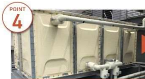
給水を受水層式から直結式に変更 受水槽を無くしたことで、共用スペースが充実
