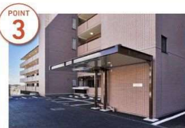
駐車場のアスファルト更新と 屋根付きの車寄せを設置
