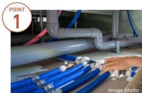
共用部の排水管の調査し、 新しい管に更新
