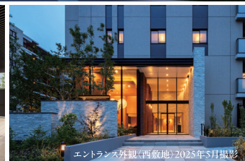
エントランス外観(西敷地)2025年5月撮影
