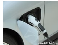
駐車場の各スペースに EV充電器設置
